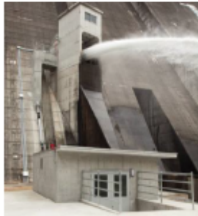
【発電設備の新設・増強】
