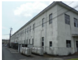
【現状施設の例(庁舎)】
