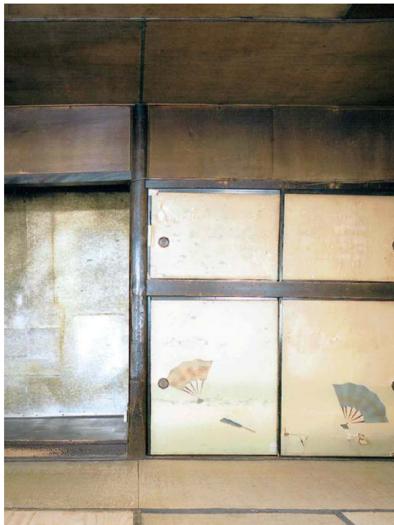
古民家内装（改装前）
