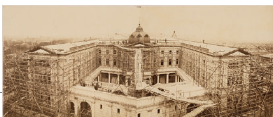
2019年 デジタルアーカイブを開設 (写真は、デジタルアーカイブ掲載の日本銀行本館の建築風景)
