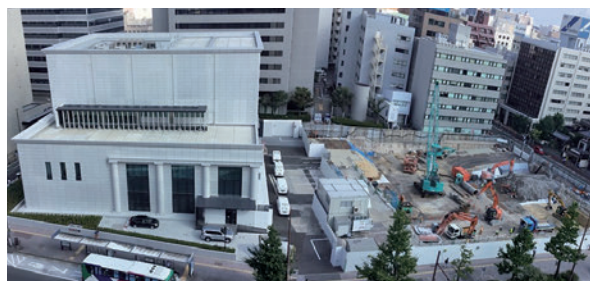
③ 2020年8月：II期棟新築工事着手。
