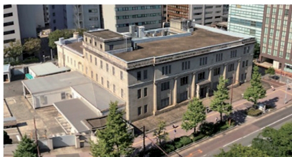
① 2017年10月：I期棟新築工事着手。
