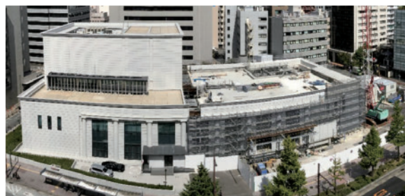
④ 2021年9月：I期棟とII期棟を接続。
