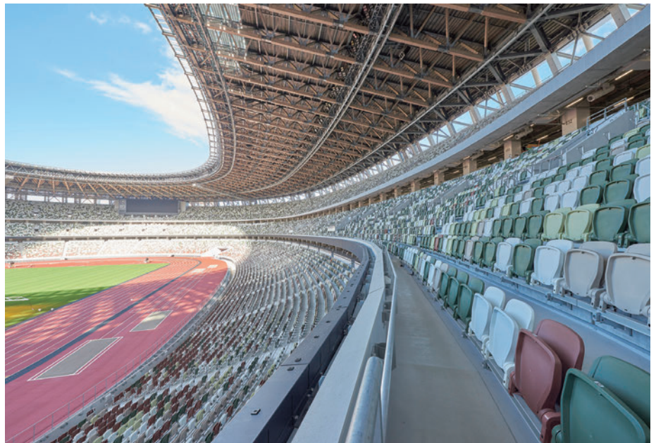
国立競技場の最上部を一周するようにつくられた「風の大庇」（写真提供：独立行政法人日本スポーツ振興センター）
