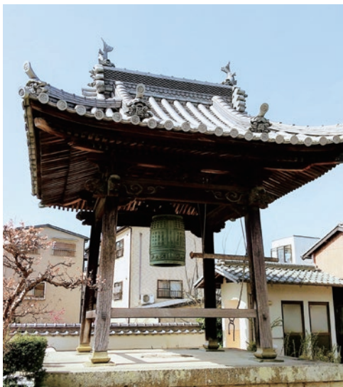
松尾は、実家の中根家（注）が檀家であった妙典寺（兵庫県加西市）に鐘楼堂を寄進した。中央の鐘は、第二次世界大戦中の金属回収令による供出のため、後に復元したもの。（写真提供：加西市観光まちづくり協会）（注）松尾は中根家に生まれ、11歳の時、松尾家の養子となった。
