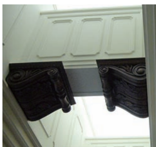
写真8 持ち送り金物 （現店舗の営業場ロビー上部）
