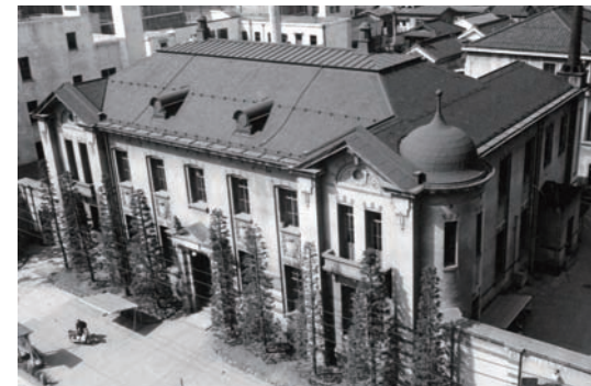
写真6 旧店舗の屋根
