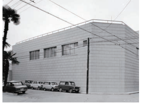
写真8 増築後の金庫館
