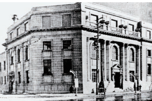
写真5 3代目函館支店の外観(新築時)
