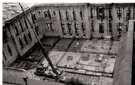
写真9 本館改修工事
