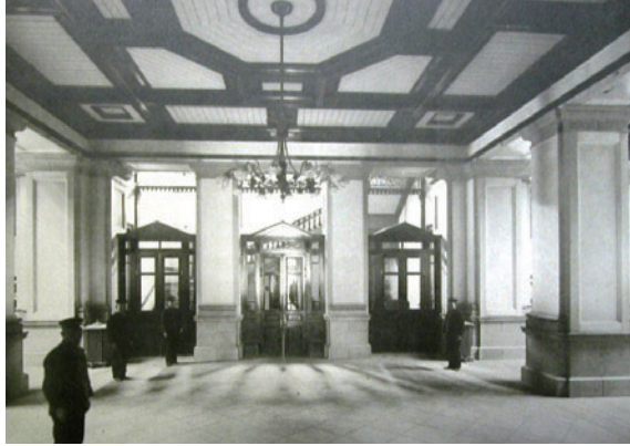
写真7 正面玄関から見る階段室 (日本銀行金融研究所アーカイブ所蔵)
