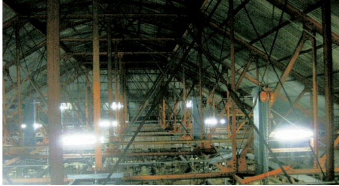
写真9 屋根裏の鉄骨トラス
