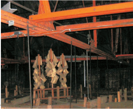
写真6 屋根裏に残る幣束
