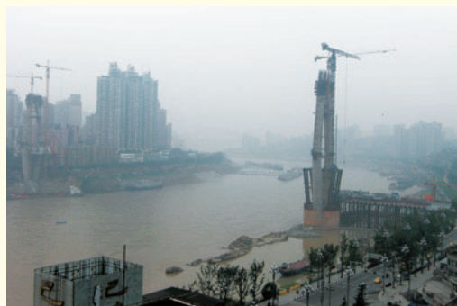
重慶市内では、長江兩岸をつなぐ大型橋梁工事等が進行中
