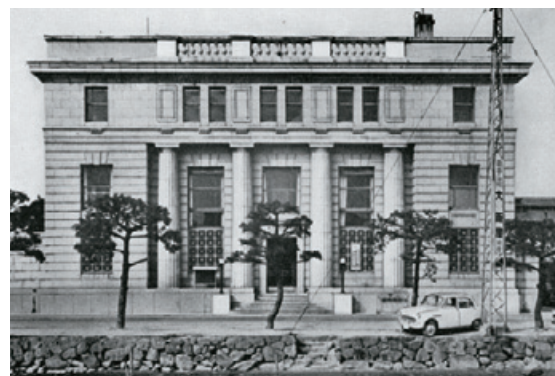
(上) 写真8 2代目の広島支店。現存する被爆建物の一つ。堅牢な鉄骨鉄筋コンクリート造りで、爆心地の至近距離ながら倒壊を免れた。(下) 写真9 2代目の松江支店。本店増築棟と共に長野宇平治の遺作
