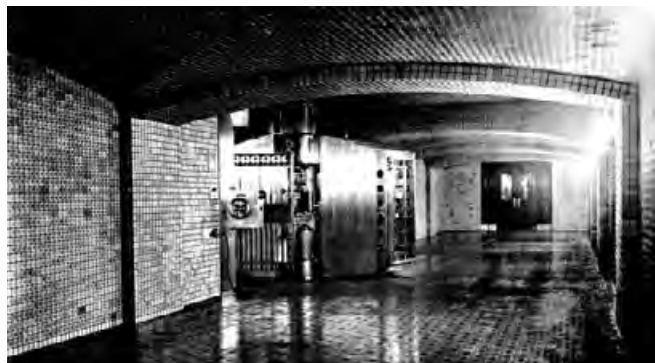
写真4 1号館地下金庫前ホール。壁・天井/黄土色のテラコッタタイル貼り、床/黒・レンガ2色のゴムタイル貼り。本館地下金庫前に当時の面影が残る。
