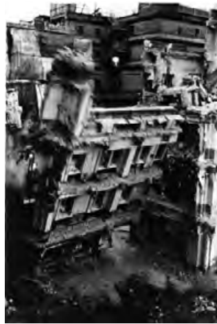
写真8 1号館解体。地上部分の解体はスチールボールによる大壁倒しが用いられた。（日本銀行金融研究所アーカイブ所蔵）
