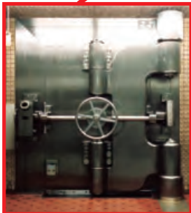
昭和7年(1932)の拡幅時に設置した金庫扉
