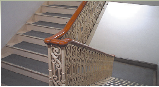
写真2 現存する東側鉄骨階段
