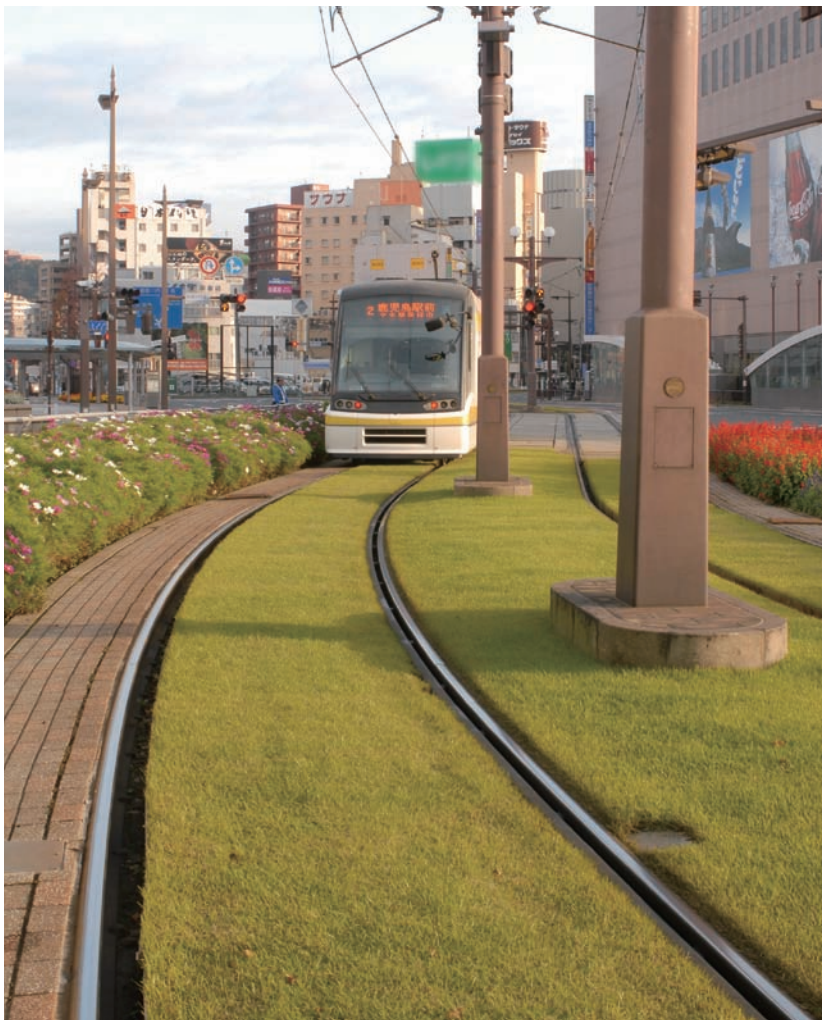
市電の軌道に敷き詰められた「シラス緑化基盤」。景観美化が実現した。
