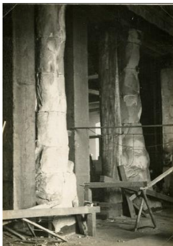
▼本館営業場丸柱
